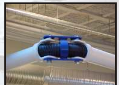
Drejeled med bøsninger og justerbare anlægsskiver.
